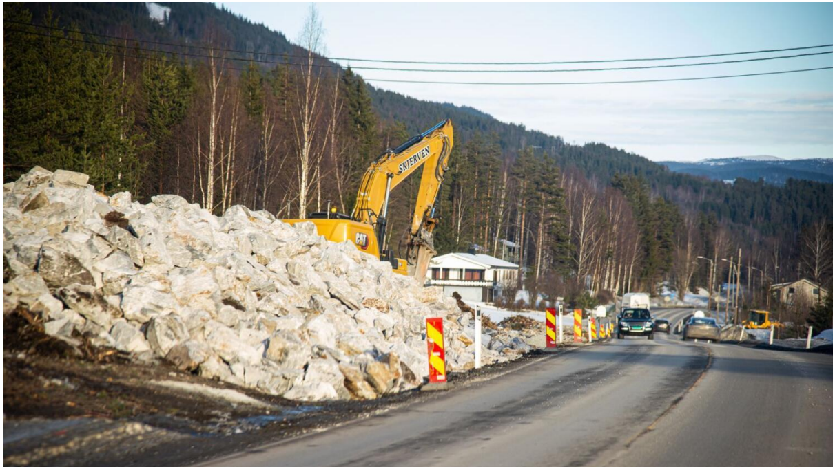
Området ved Rotnheim hvor utbedring er i gang. NLF mener det må gjøres mer. Foto: Knut Olav Kvissel
